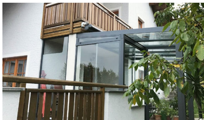
Glasanbau unter bestehendem Balkon – vorhandene Bausubstanz clever genutzt.
